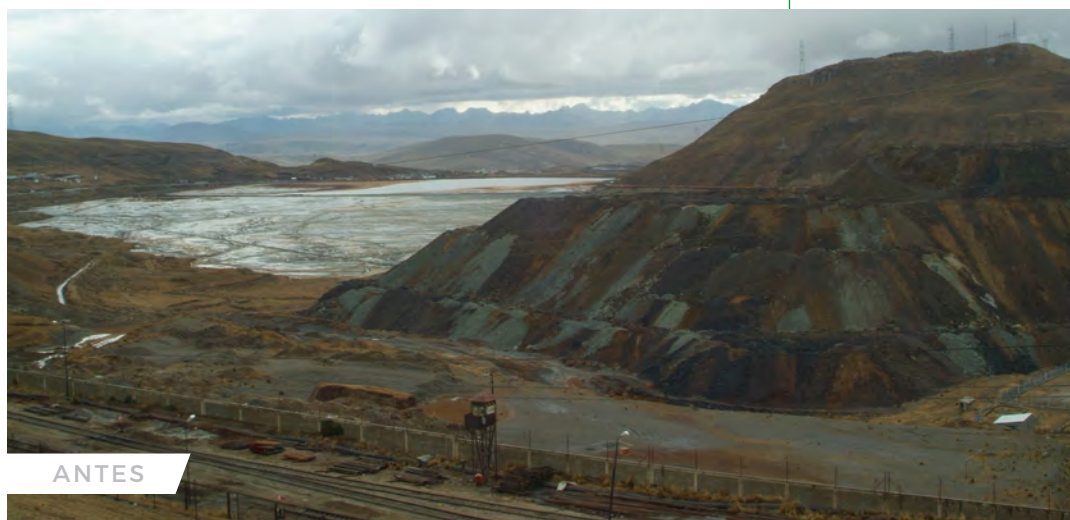
Botadero de Desmontes Excélsior.
