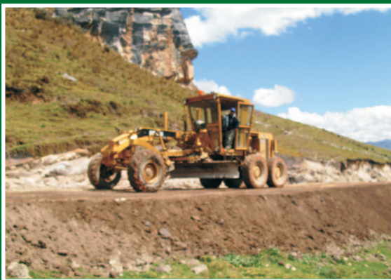
Mantenimiento de trocha carrozable / Dirt road Maintenance
