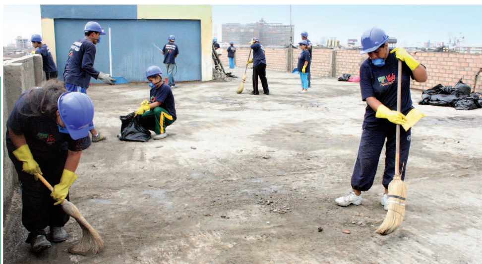
Callao: Limpieza de techos en el AA.HH. Puerto Nuevo.
