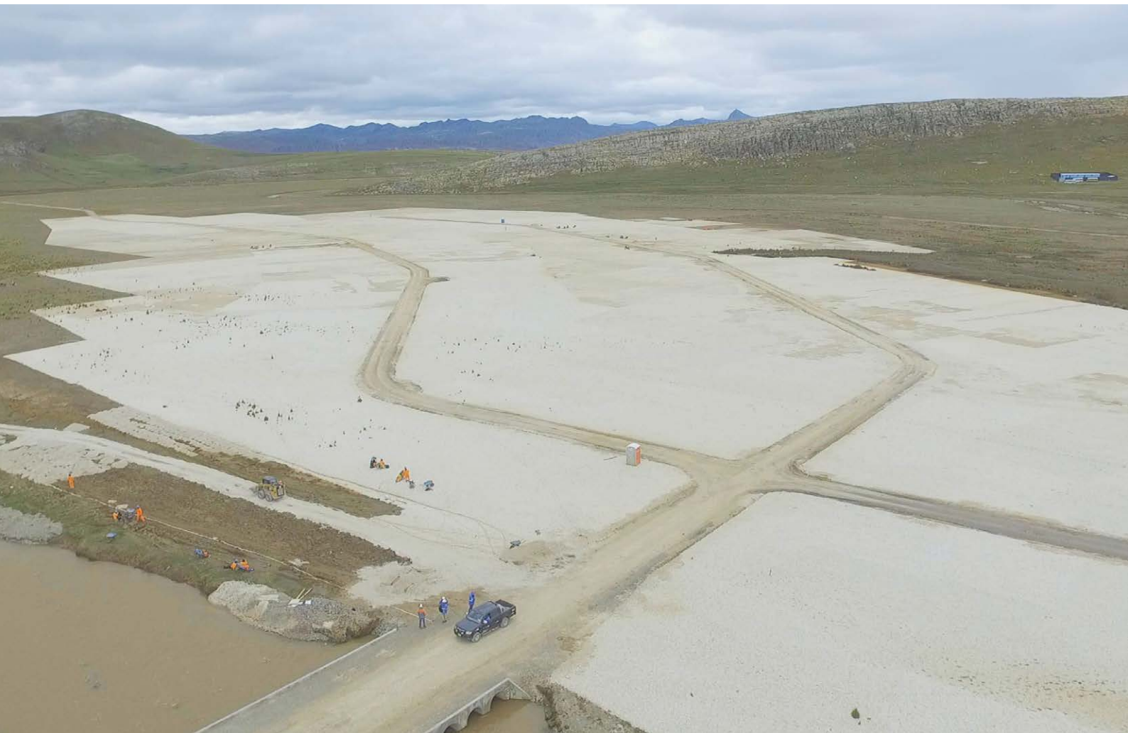
Ejecución de Obra Plan de Cierre Integral Río San Juan Delta Upamayo, distrito de Vicco, provincia y región Pasco.
