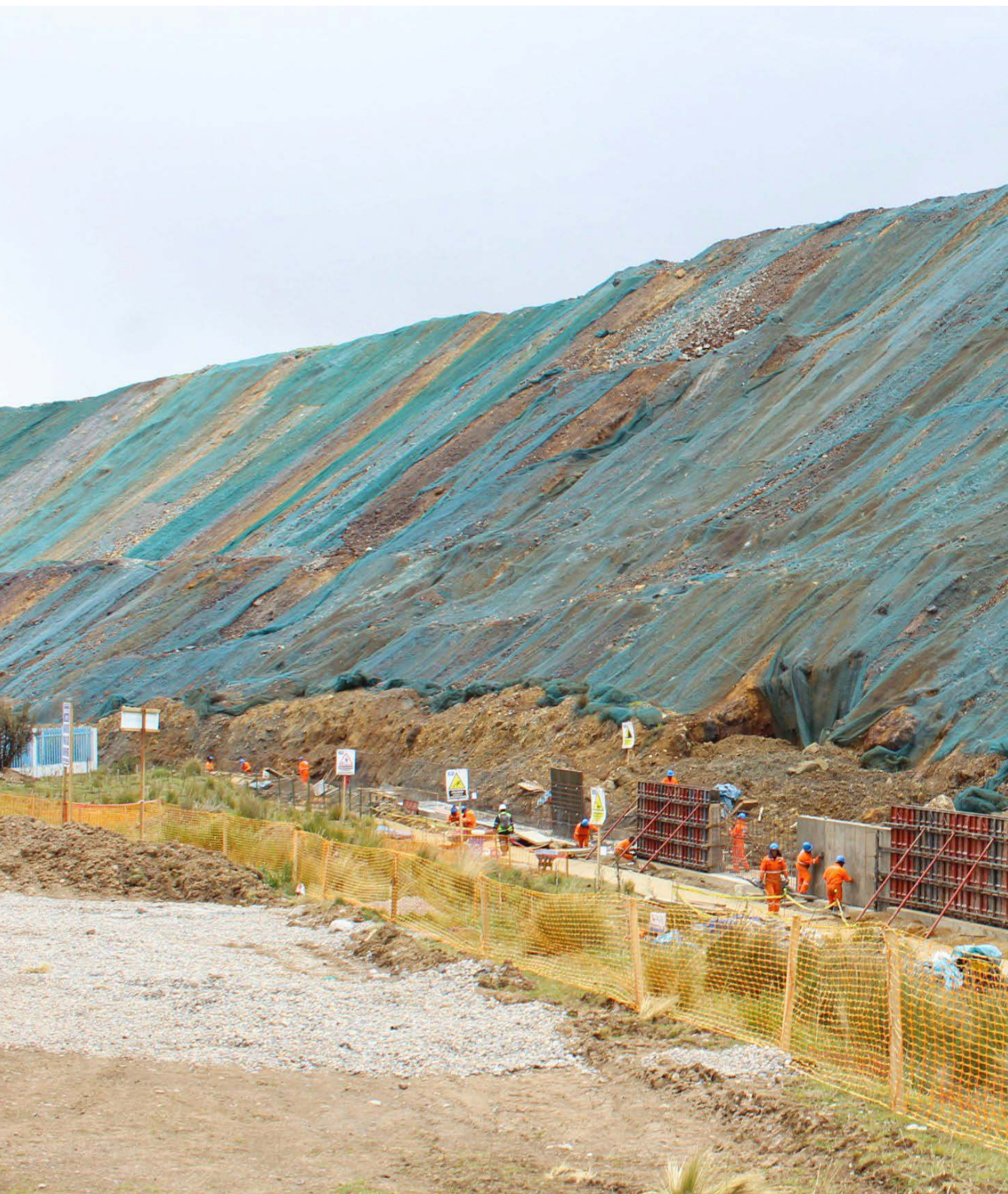
Ejecución del Plan de Cierre Excélsior, primera etapa, distrito de Simón Bolívar, provincia de Pasco
