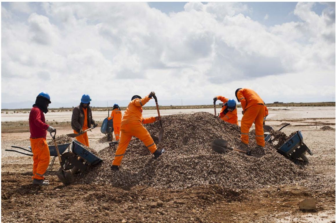
Extendido de piedra caliza en el Delta Upamayo, distrito de Vicco, provincia de Pasco.
