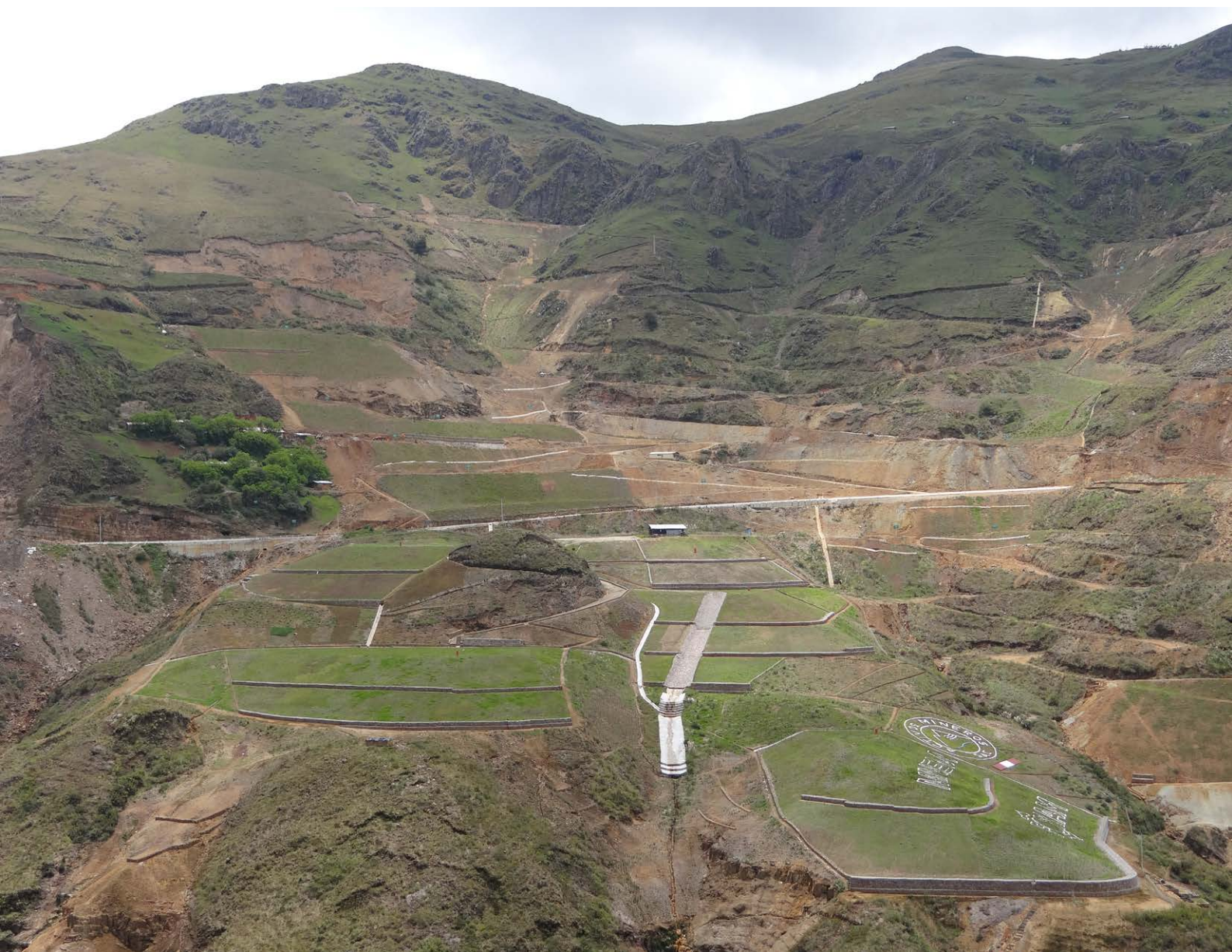
Depósito remediado, Cinco Relaveras El Dorado, distrito de Hualgayoc, Bambamarca, Cajamarca.
