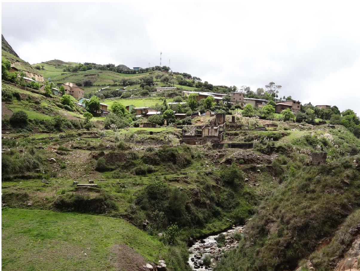
ANTES Ex Unidad Minera Dorado Barragán previo a la intervención, distrito de Hualgayoc, Bambamarca, Cajamarca.
