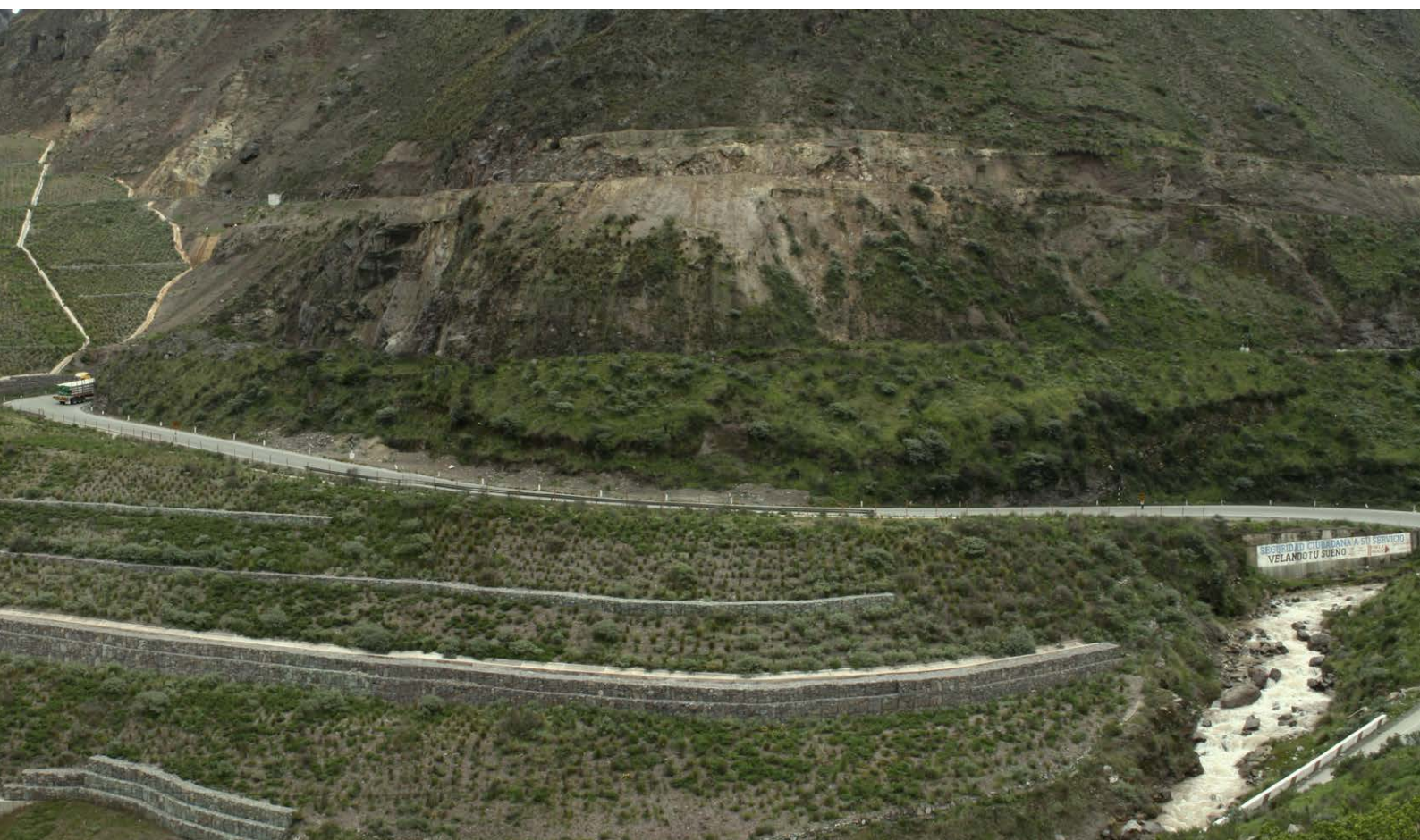
Depósito remediado Tablachaca, ubicado en el distrito de Chicla, Huarochirí, Lima.
