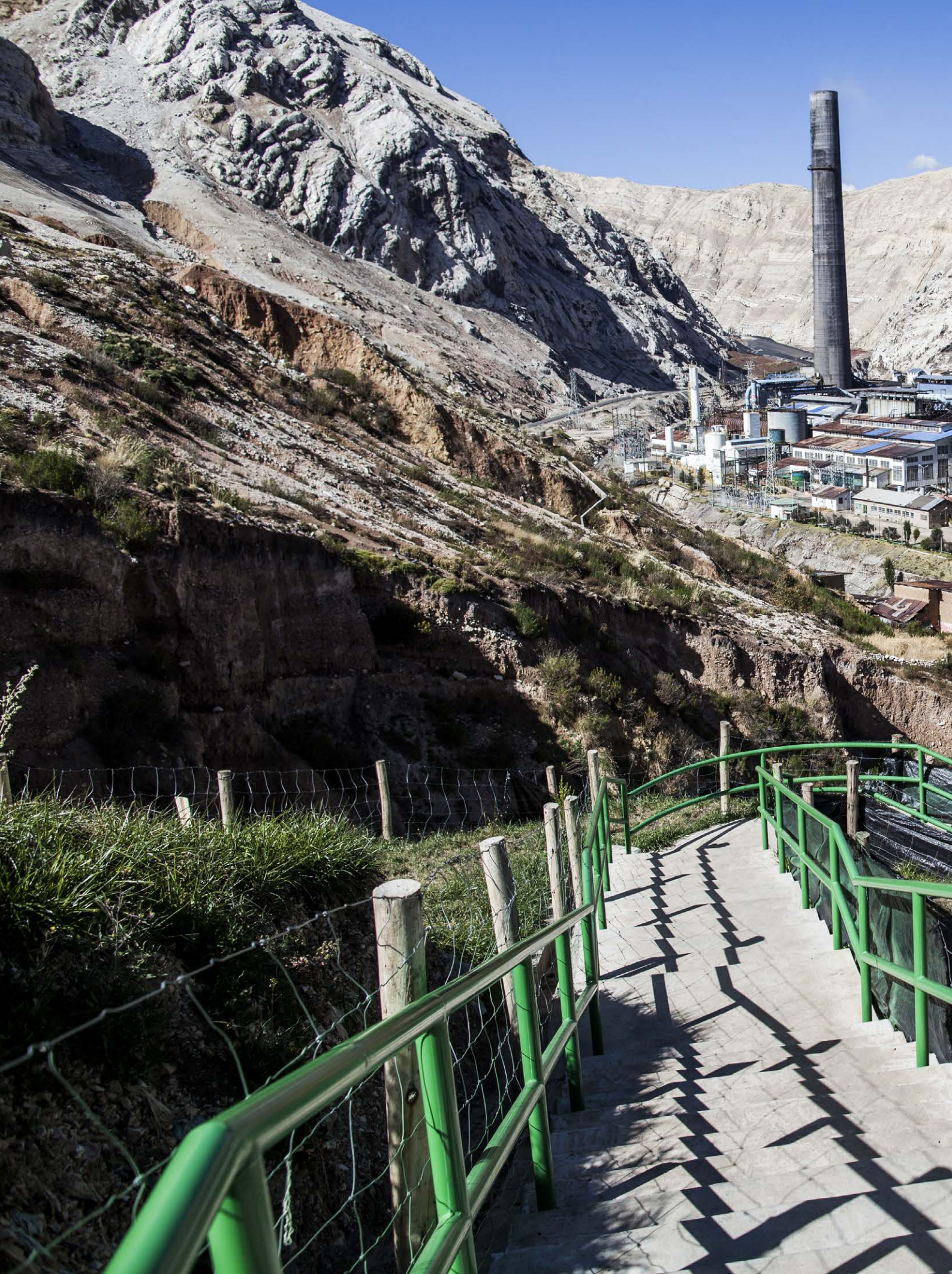
Remediación de Suelos de La Oroya, distrito de La Oroya, provincia de Yauli, Junín.
