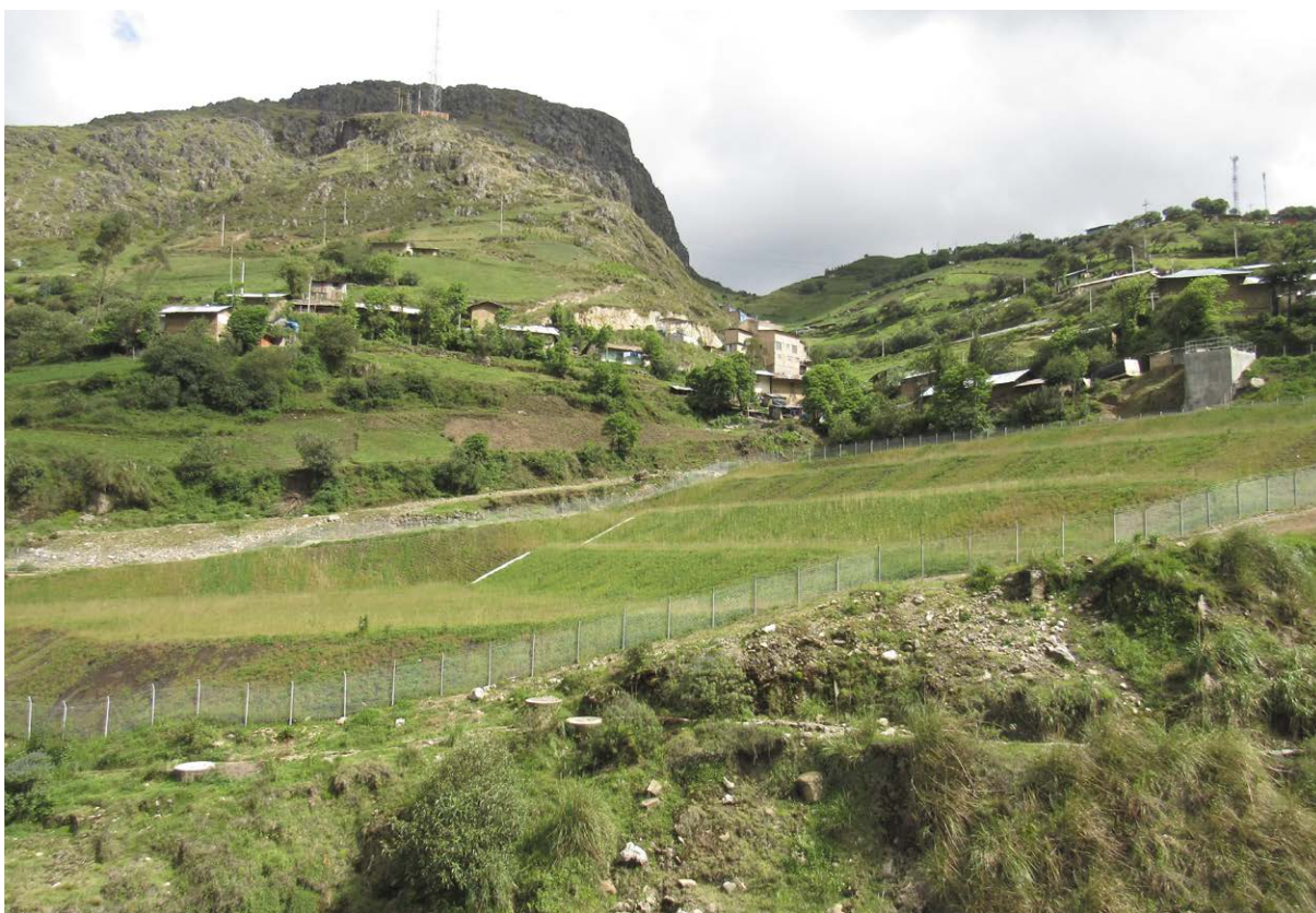
AHORA Remediación Dorado Barragán, después de la intervención, distrito de Hualgayoc, Bambamarca, Cajamarca.
