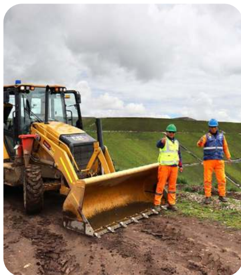
Trabajadores en el proyecto Excélsior.
