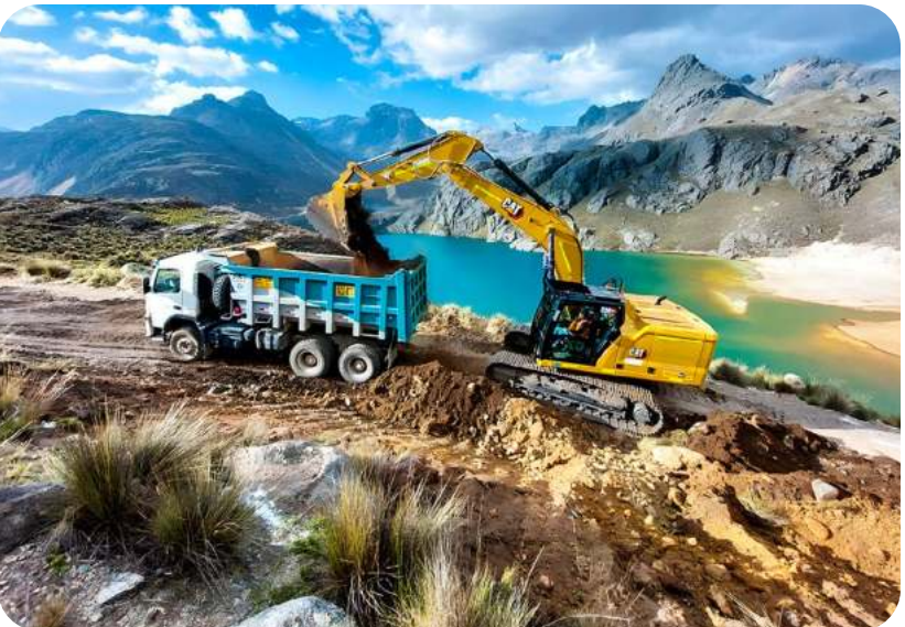
Ejecución de obras en el Proyecto Caridad.
