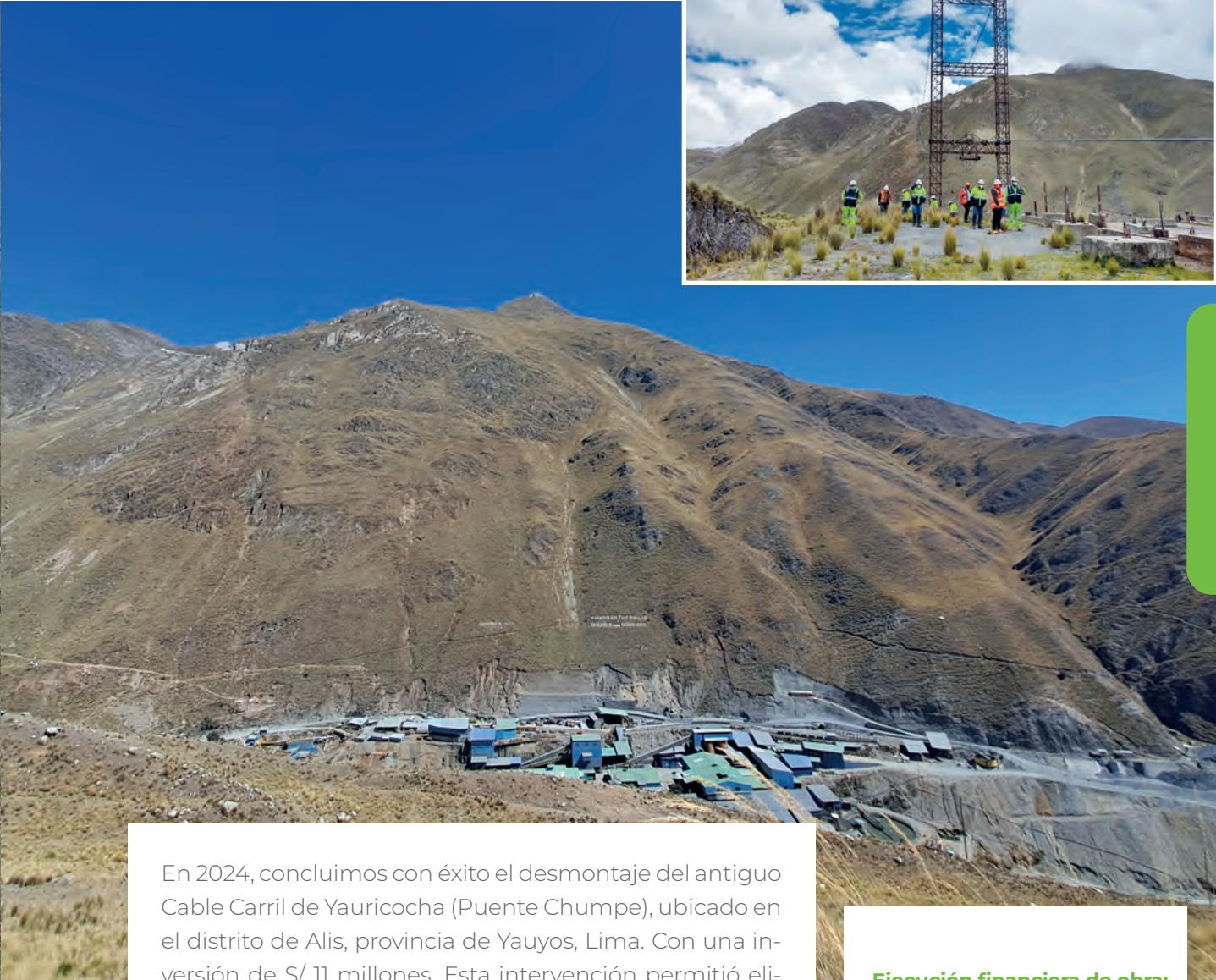
DESMANTEAMIENTO DEL PUENTE CHUMPE
